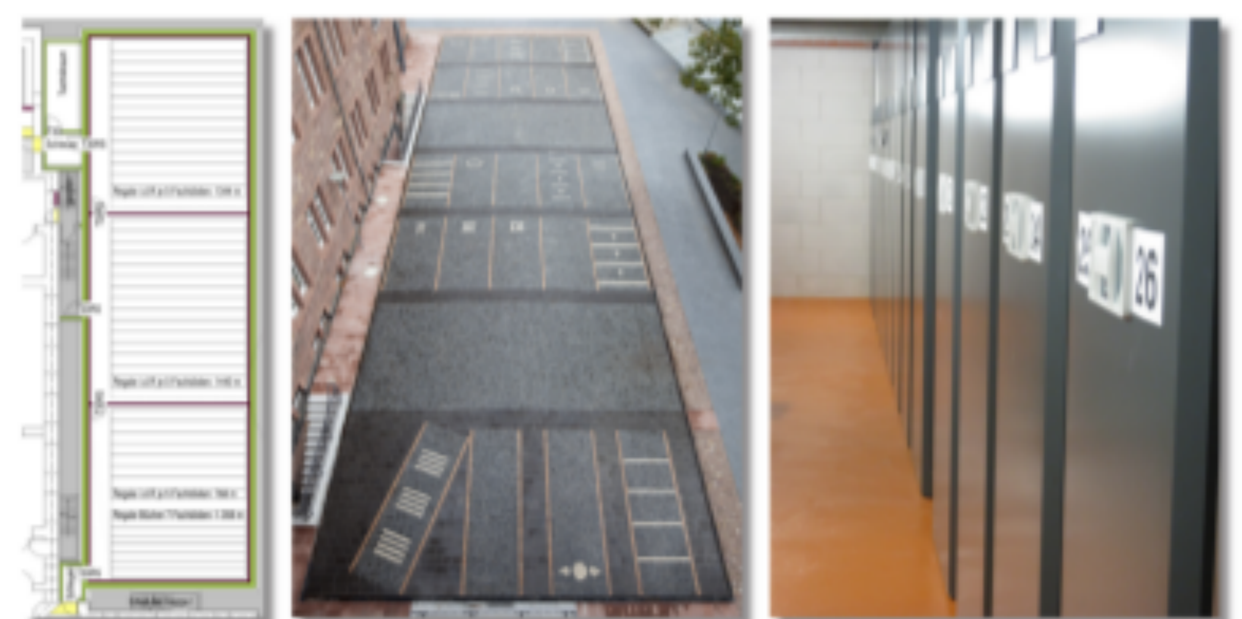
Links: Auszug aus der Bauplanung des neuen Tiefmagazins Mitte: Neues Tiefmagazin unter dem Parkhof Rechts: Rollregalanlage im neuen Tiefmagazin
